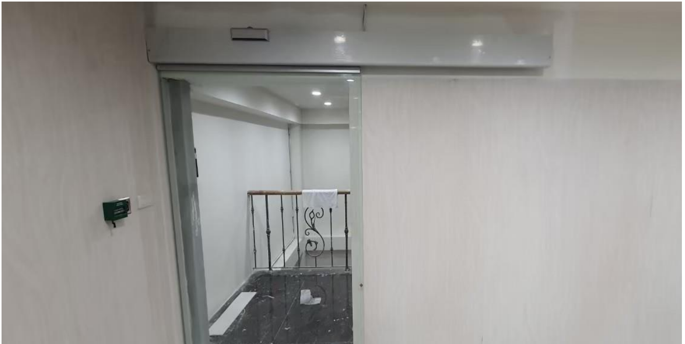
Project: กรมเจ้าท่า / Model: HKD – 150W / System: Auto Sliding Door
